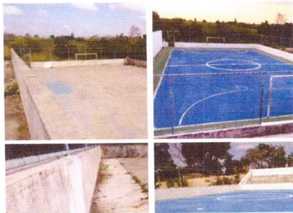
Figura 5 - Reforma da quadra do Residência Ramalho, antes e depois.
