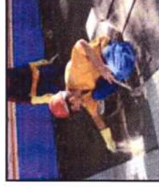
Aplicação de cimento pulverizado e água (etapa não necessária para argamassa colante).
