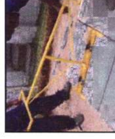
Colocação das peças de concreto com saca-placas.
