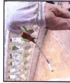
Execução de juntas de controle, lavagem, aplicação de resinas e liberação ao tráfego.
