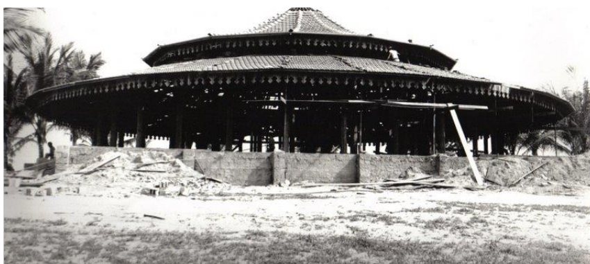
Figura 4. Construção do Clube Jacarandá
