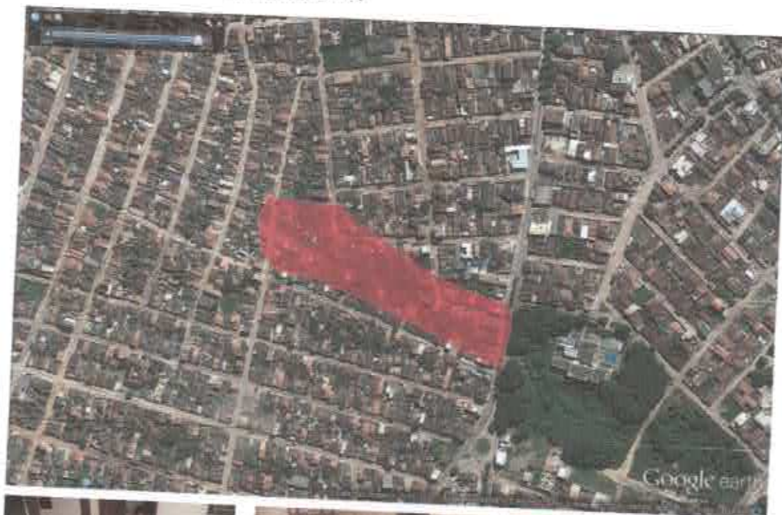
FIGURA 40 - CÔRREGO MONTE CASTELO (RUA DO PÓ)
