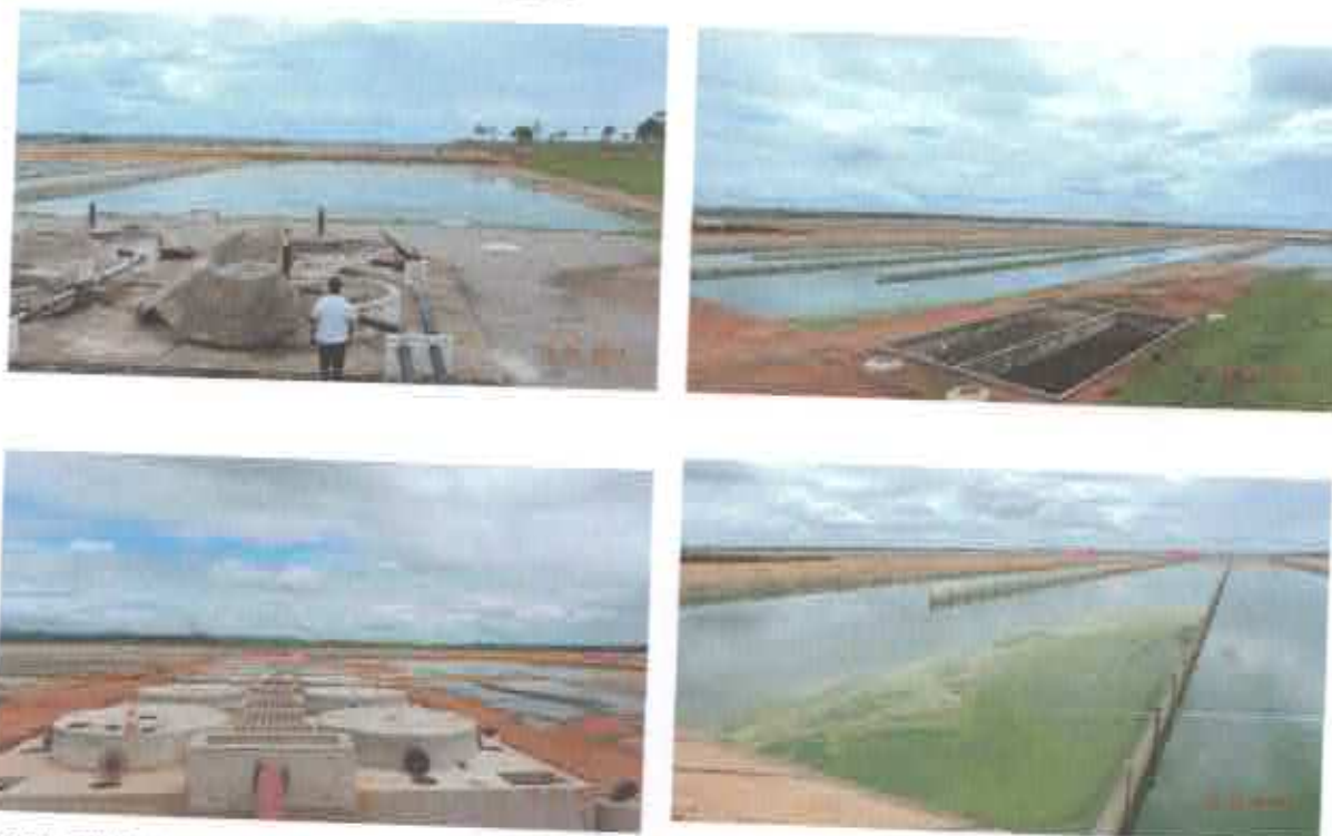
FIGURA 20 - ETE - ESTAÇÃO DE TRATAMENTO DE ESGOTO
