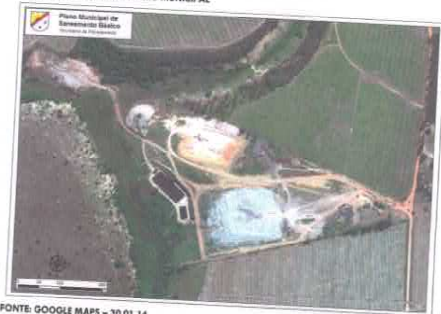
FIGURA 70 - ATERRO SANITÁRIO MUNICIPAL
